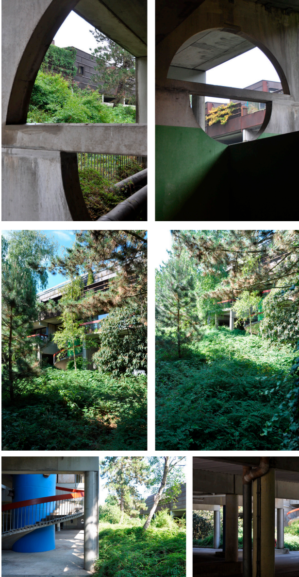
Fig.2-4. Farum Midtpunkt housing estate.
