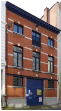
11 1894 Headquarters Oude Buildragersnatie 8, De Waghemaekerstraat
