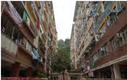
Fig. 9. Ming Wah Dai Ha Estate. Façade. © Niccolò A. Galliano, 2023.
