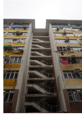
Fig. 16. Ming Wah Dai Ha Estate. Vertical Access. © Niccolò A. Galliano, 2023.
