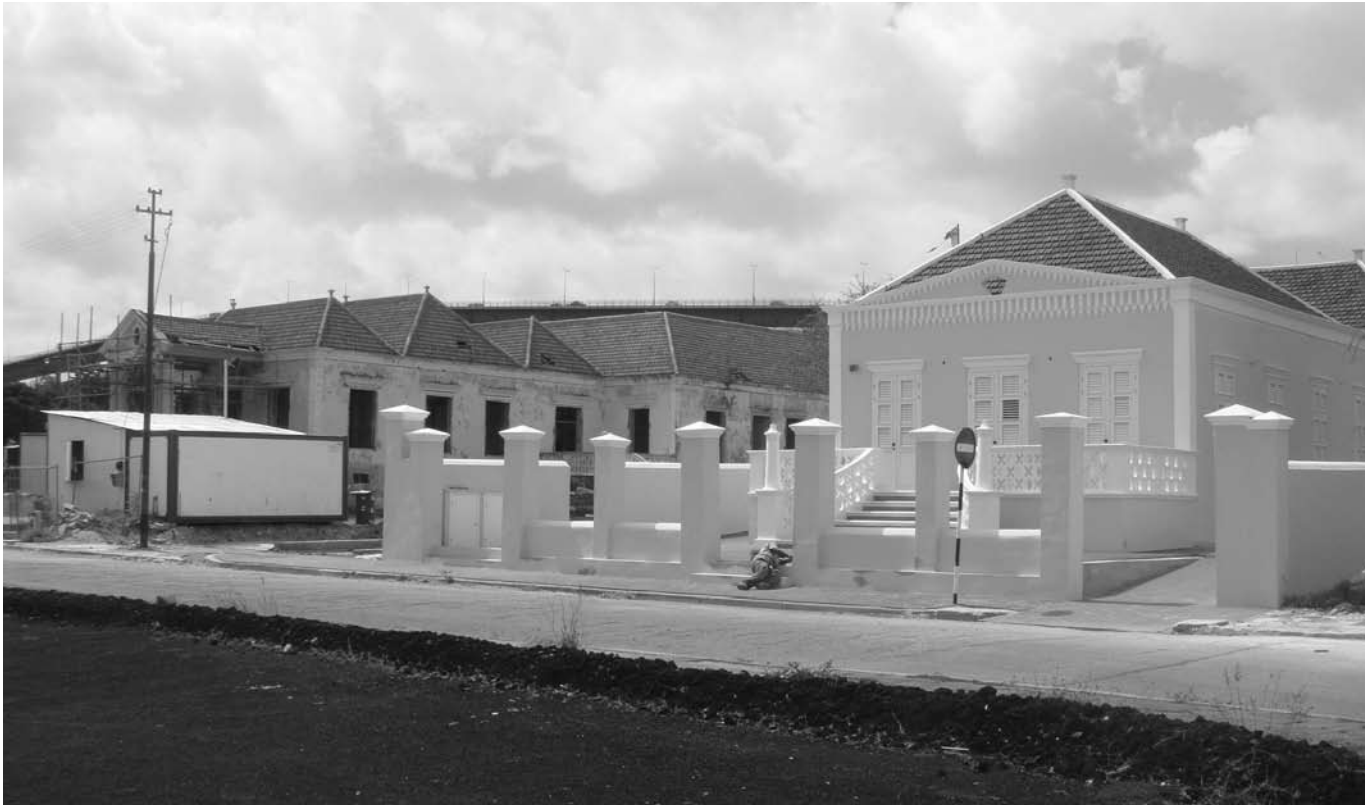
Afb. 6. Willemstad, recente restauratiewerkzaamheden in Scharloo door N.V. Stadsherstel, Bargestraat 53-55 en Bargestraat 57 (foto auteur 2009)
