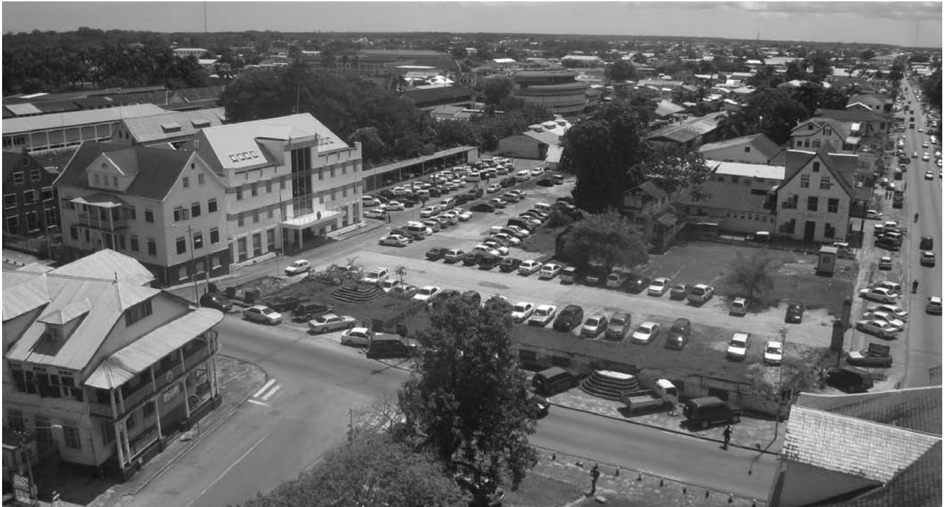
Afb. 7. Paramaribo, zicht op de overblijfselen van de panden aan de voormalige Gravenstraat 4 -6, hoek De Mirandastraat / Henck Arronstraat met zicht richting het noorden op de Grote Combéweg. (foto auteur 2008)
