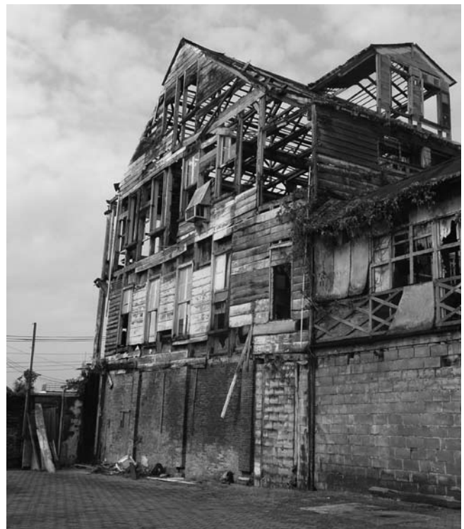
Afb. 10. Paramaribo, houtskelet aan de Waterkant (foto Philip Dikland 2008)
