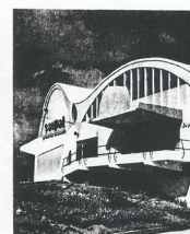
1 — Estação de Serviço e escritório.
