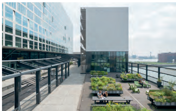
Dakterras op het semi-openbare plein Roof terrace on the semi-public square
