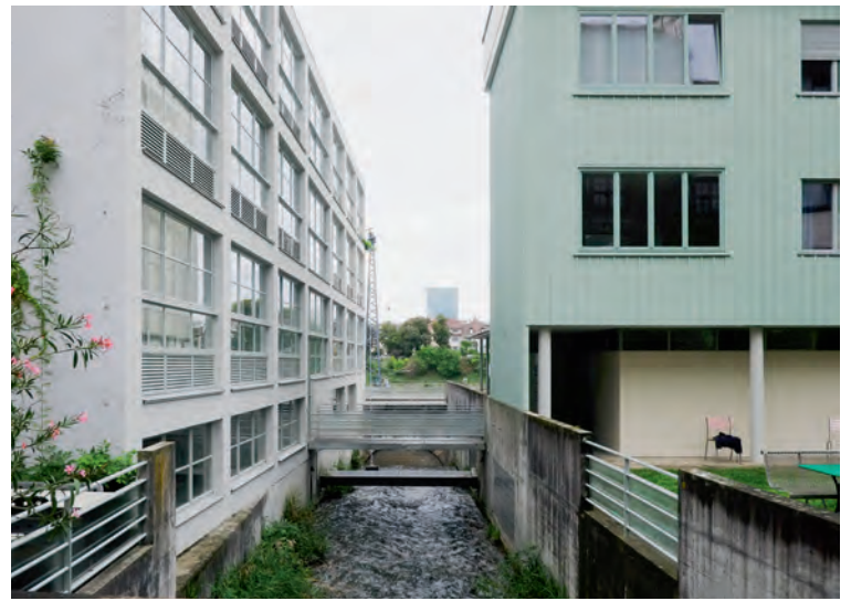
Loopbrug tussen twee gebouwen Footbridge between two buildings
