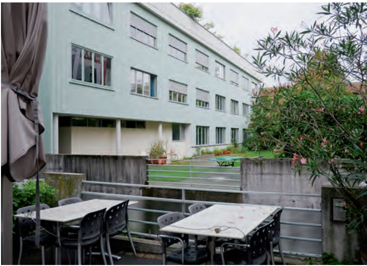
Board and batten tuingevel aan de zuidzijde Board and batten garden façade facing south
