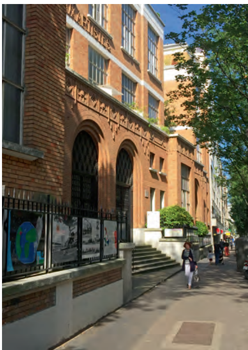
Baksteenreliefs articuleren de hoofdentree Brick reliefs articulate the main entrance
