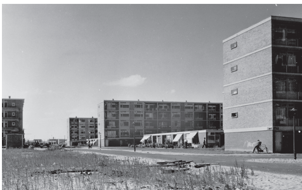
Het complex in aanbouw, 1959 The complex under construction, 1959
