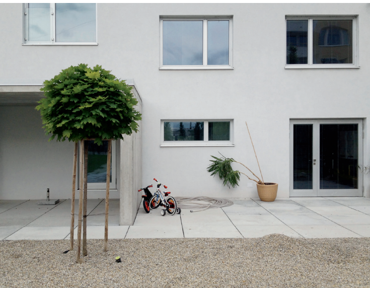
De nieuwe plint van het gebouw New building plinth
