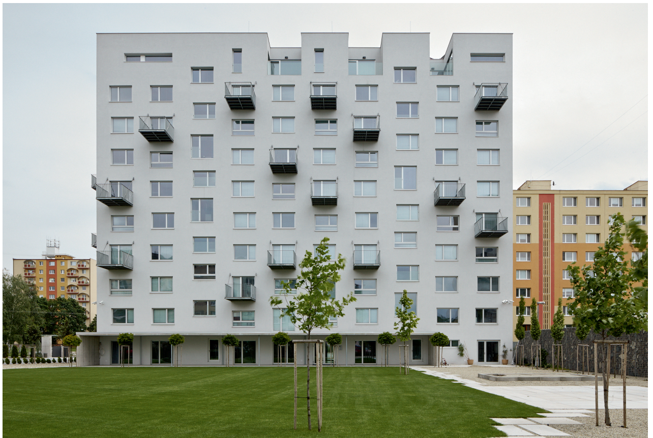
Nieuwe gevel na de transformatie New façade after the transformation
