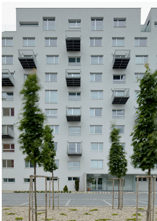
Nieuwe gevel aan het parkeerterrein New façade along the car park
