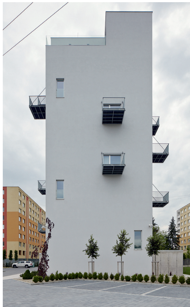
Nieuwe kopgevel New end wall
