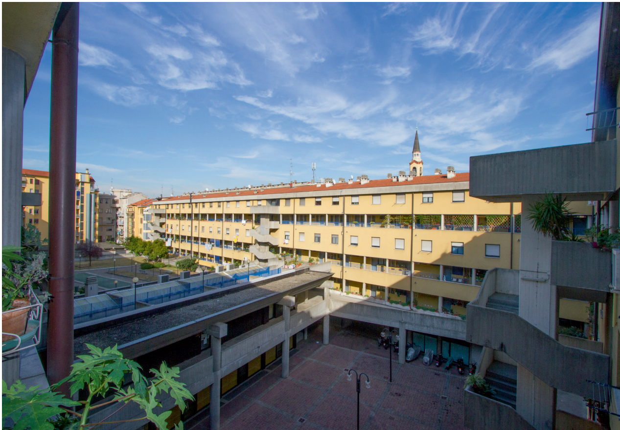
Zuidzijde van de hof, met een als openbaar toegankelijk bedoeld plein South side of the courtyard, with a square intended for public use
