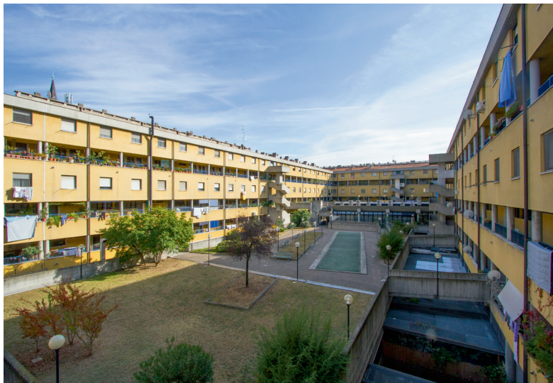
Hof met galerijen rond de gezamenlijke tuin op het dak van de parkeergarage Courtyard with walkways round the communal garden on the roof of the car park
