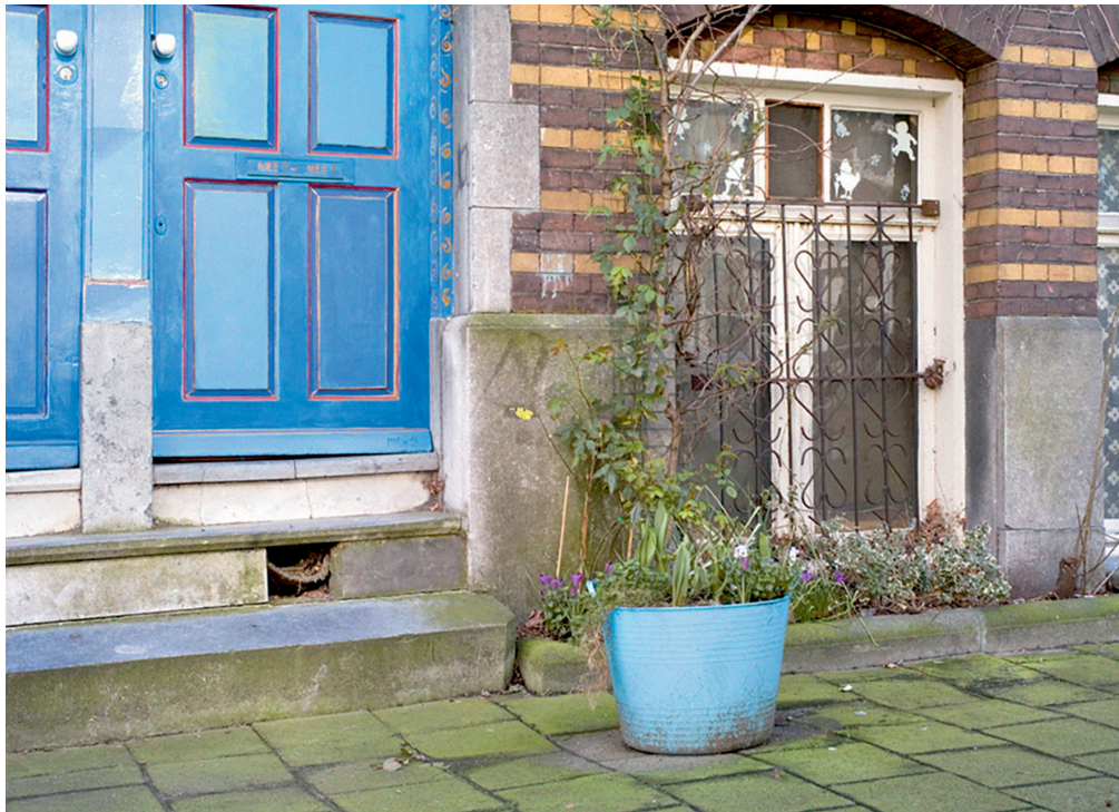
Zwaerdecroonstraat, Rotterdam; toestand van de gevel voor de transformatie Zwaerdecroonstraat, Rotterdam; condition of the façade prior to the transformation
