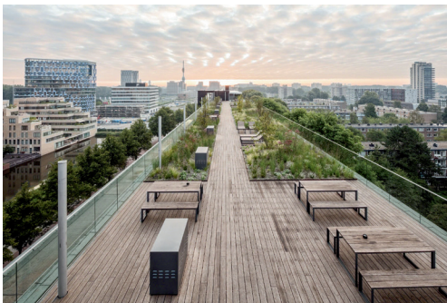
De Boel, Amsterdam, 1964. Hans van Heeswijk architecten, 2016. New roof garden
