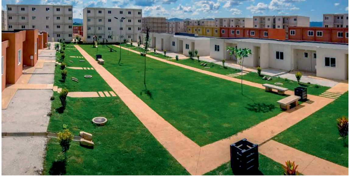
Groene zone met aan weerszijden laagbouwoningen Green zone with low-rise housing on both sides
