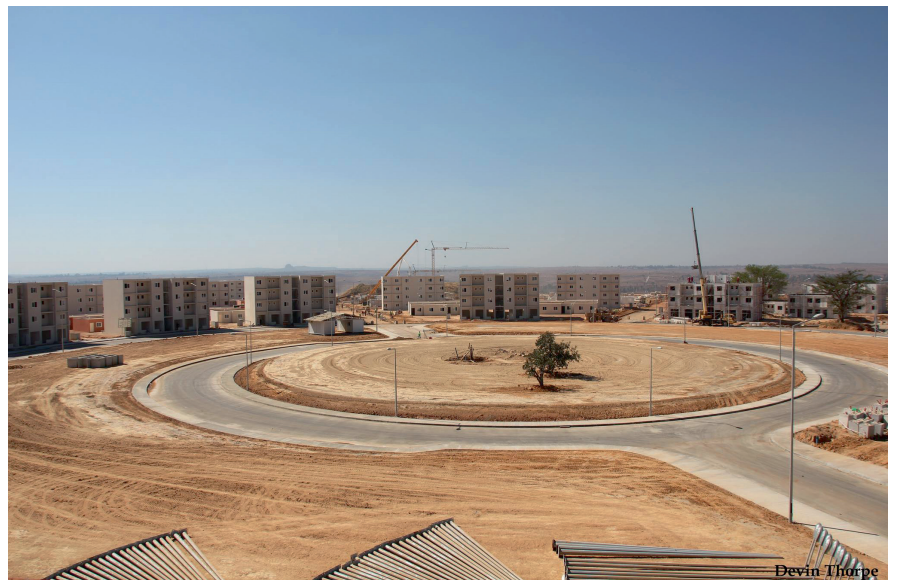
De bouw van Lossambo Lossambo under construction
