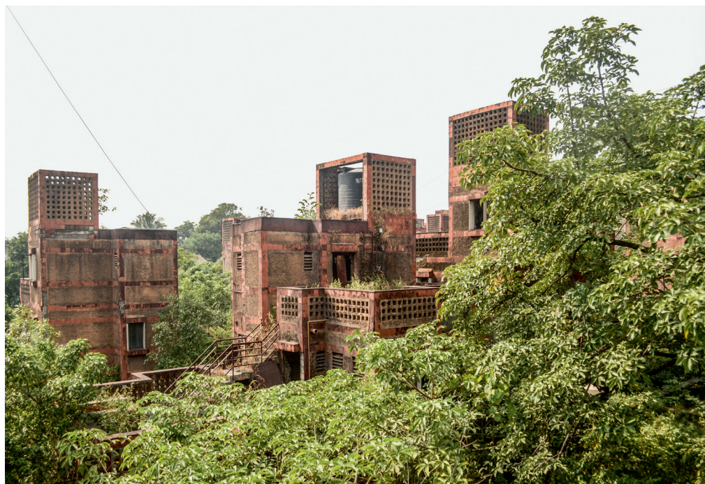
Een systeem van open trappen, als verlengstuk van de voetpaden, verbindt de begane grond met de dakterrassen
