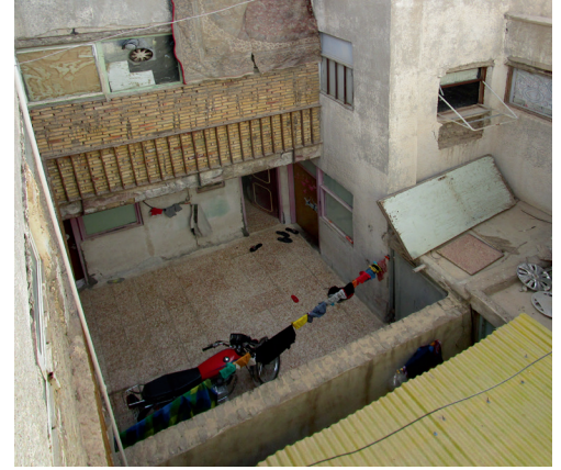
Gestapelde woningen (type 3) met galerij-ontsluiting. De originele galerijen op de verdiepingen zijn bij de woning getrokken of beschermd tegen inblik.
