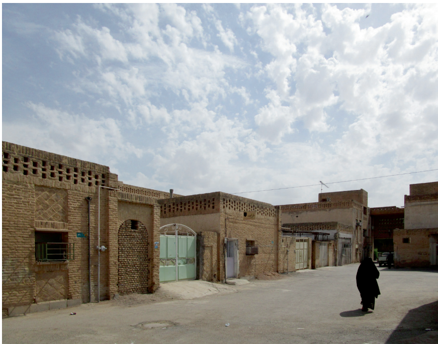
De patiowalls langs de straat zijn vaak afgebroken om de woningen toegankelijk te maken voor auto's. The patio walls bordering the street are often demolished to allow room for car access.
