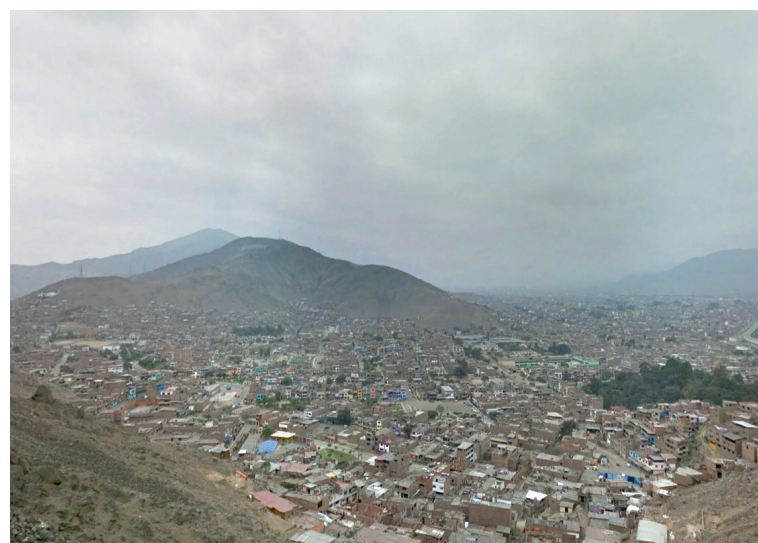
Caja de Agua en Chararilla de Otero, 2014 Caja de Agua and Chararilla de Otero, 2014
