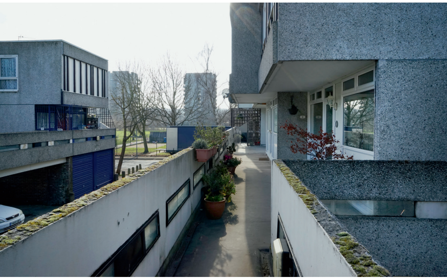
Balkonniveau van een van de laagbouwblokken Access level of one of the low-rise housing blocks
