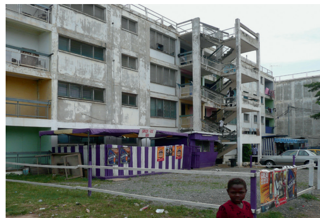
'Segeco appartementen' voor de middenklasse, 2007 Segeco apartments with middle-income apartments, 2007
