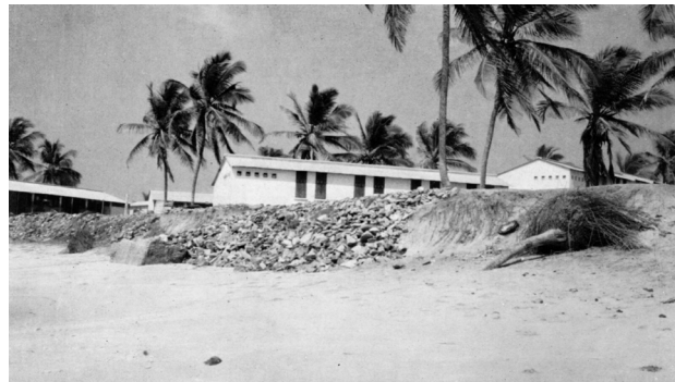
Erosie van het strand van Awudung. De Tema Development Company plaatste stenen in een poging de palmbomen en huizen te beschermen, 1966. Erosion on the beach in Awudung. Stones have been placed by the Tema Development Company in an effort to protect the palms and houses, 1966.
