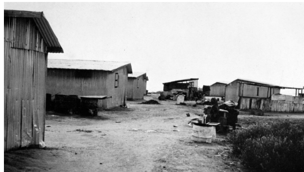
De 'Zinc Huts' werden in 1959 gebouwd als noodwoningen. In 1964 werden ze nog steeds bewoond en nu zijn ze onderdeel van de krottenwijken van het dorp. The 'Zinc Huts'. Built as emergency accommodation in 1959, these houses were still occupied in 1964. Nowadays these huts are part of the slums in the village.
