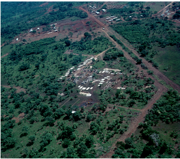
Luchtfoto, tijdens de bouw: buurt II Aerial view, construction phase: Neighbourhood II
