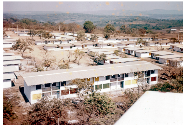
Luchtfoto tijdens de bouw (op de voorgrond woningtype B) Aerial view, construction phase (Type B houses in the foreground)
