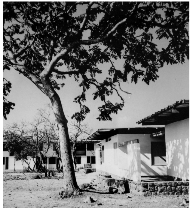
Buurt II: binnenplaats met type A en type B woningen Neighbourhood II: Courtyard with Type A and B houses
