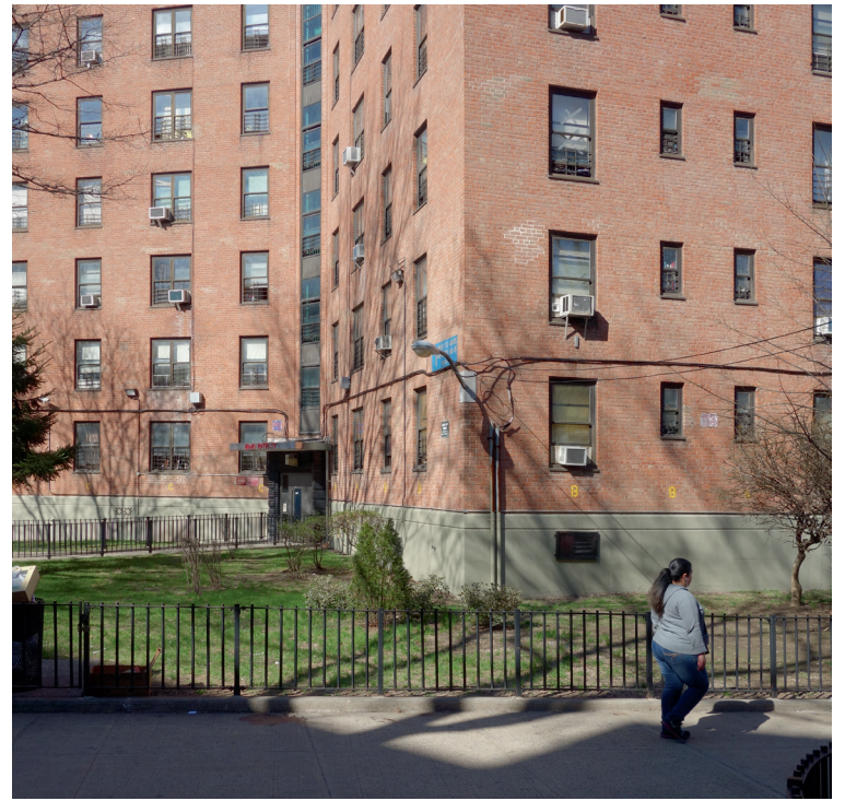
Entree van een van de noordelijke blokken Entrance of one of the northern blocks
