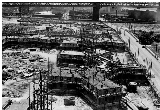
Luchtfoto van het Queensbridge project tijdens de bouw, mei 1939 Overhead view of the construction of the Queensbridge project, May 1939
