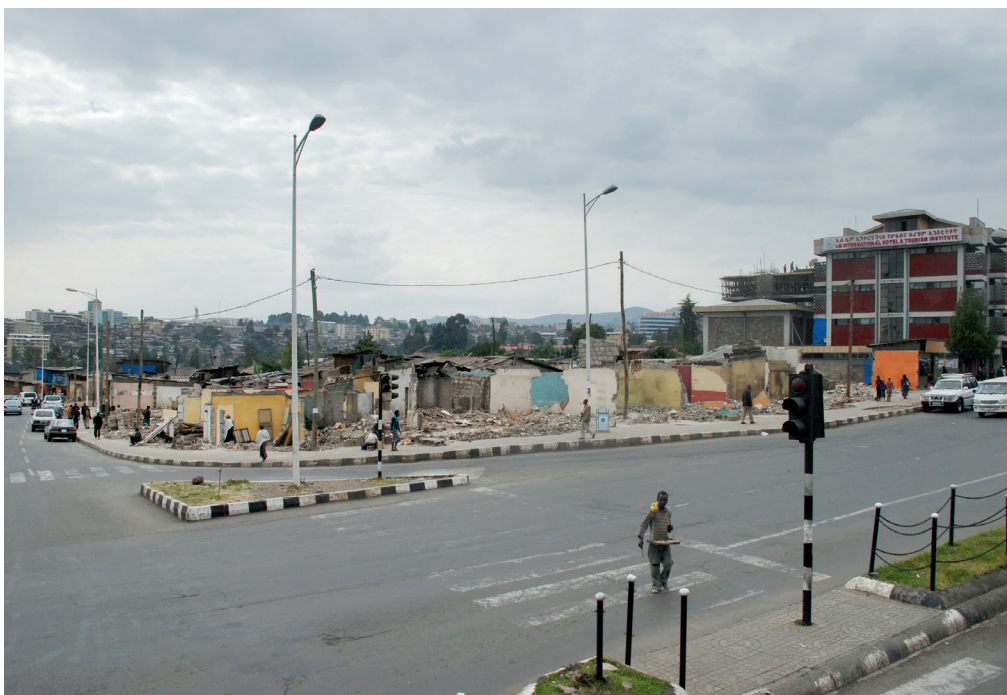
Sloop van kebele -huizen om plaats te maken voor woningbouw- en andere ontwikkelingen Demolition of kebele houses to make place for housing and other developments
