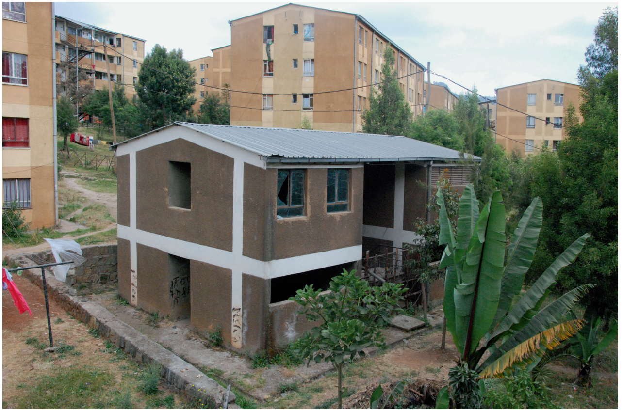
In onbruik geraakt gemeenschappelijk gebouw Abandoned common building
