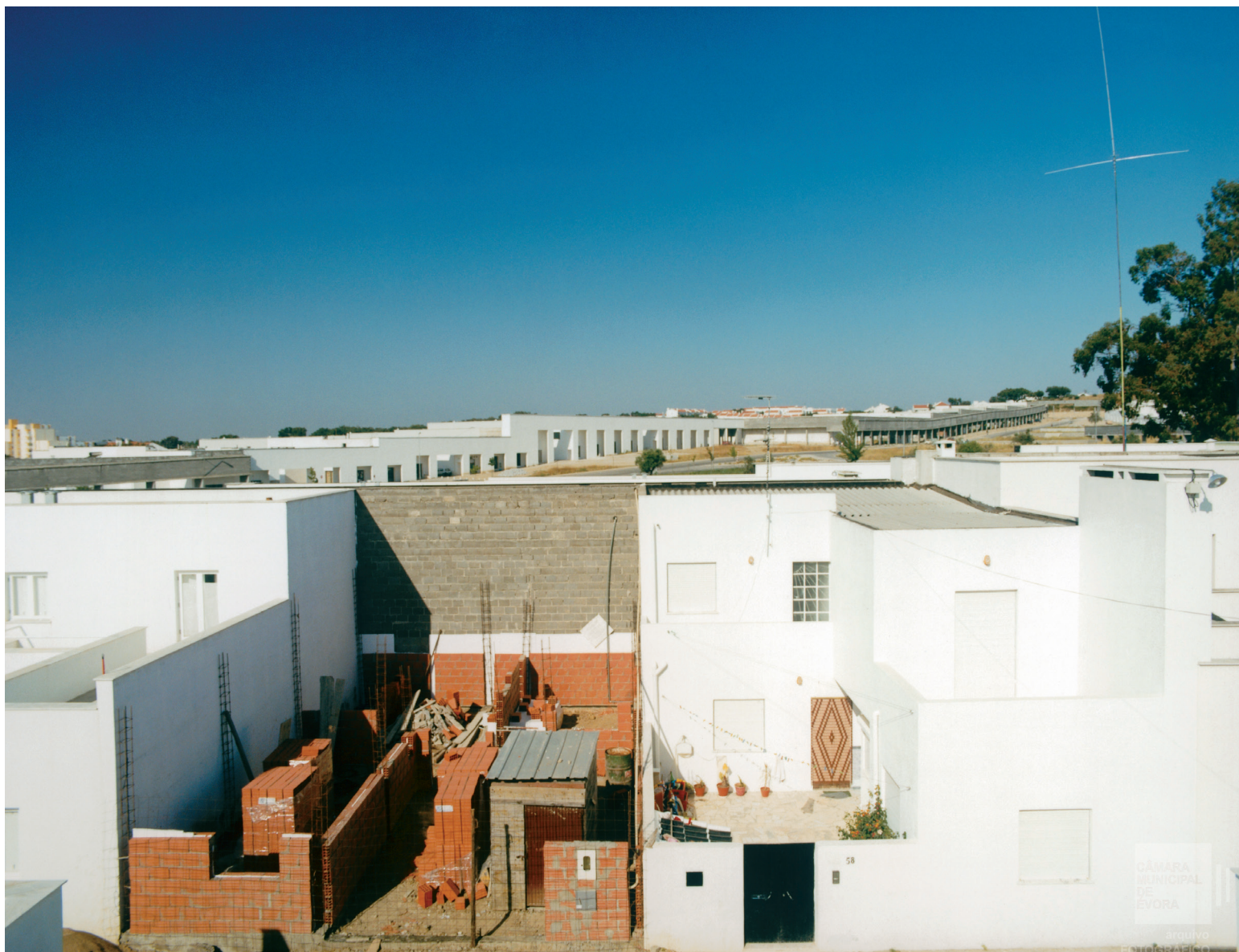
Een woning in aanbouw in de wijk Malagueira, Évora, Portugal, met de conduta op de achtergrond, 1990 View of a house under construction in the Malagueira neighbourhood, Évora, Portugal, with the conduta in the background, 1990
