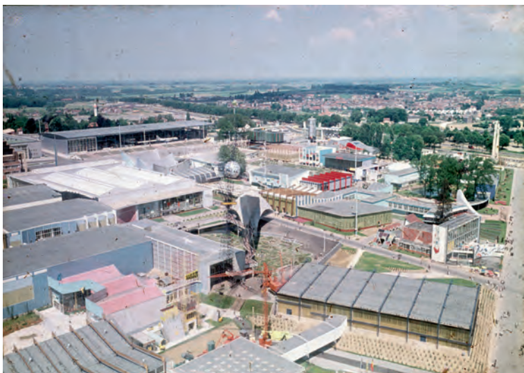
Luchtfoto van de Belgische Sectie, Expo 58, Brussel, 1958 Aerial photo of the Belgian Section, Expo 58, Brussels, 1958
