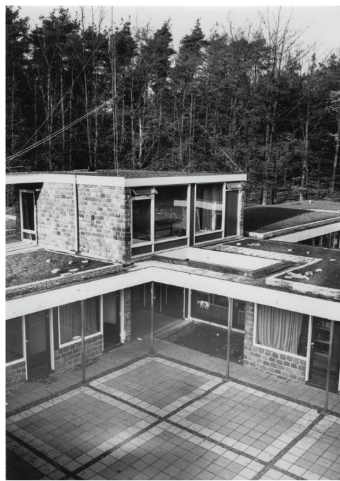
Kleine patio met bovengelegen 'mentor'-kamer Small patio with 'wardens' room above
