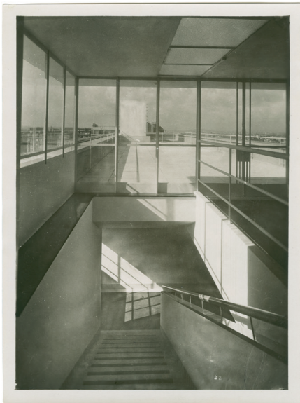
Zicht op het dakterras View of the roof terrace
