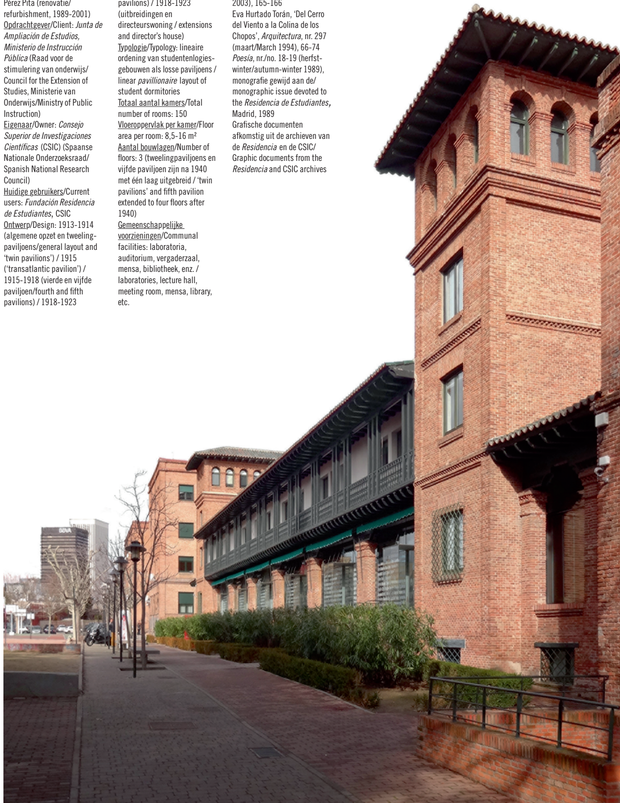
Westgevel van het Transatlantisch Paviljoen van de Residencia de Estudiantes in Madrid, huidige staat West façade of the 'transatlantic pavilion' at the Residencia de Estudiantes in Madrid, current state
