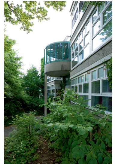
De portieken van Hertzberger manifesteren zich op de tweede verdieping als een uitkragende overloop die uitnodigt tot verblijven
