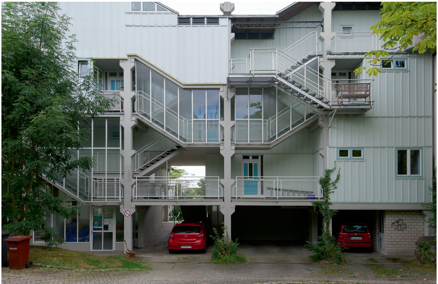
Noordgevel met het expressieve Laubentreppenhaus , zoals Steidle het noemde North façade with the expressive Laubentreppenhaus , as Steidle called it
