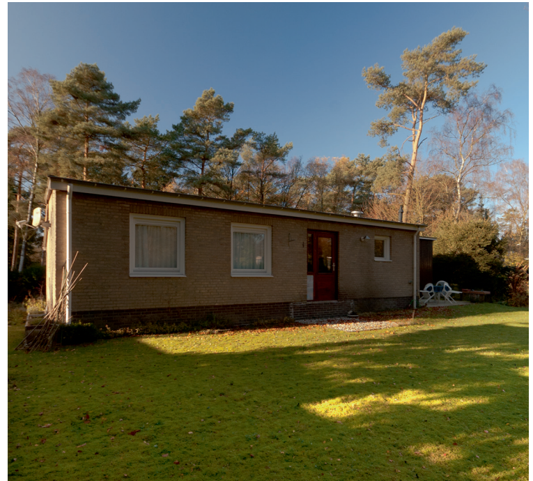
Oostgevel Zweedse bungalow East façade of the Swedish bungalow
