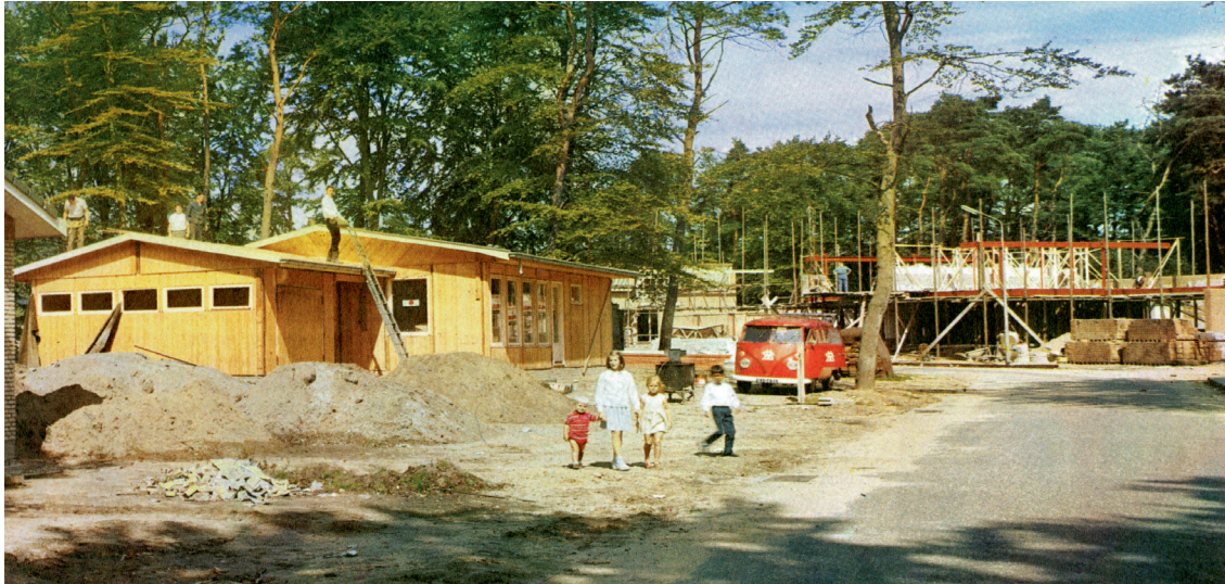
Plan Internationaal tijdens de bouw Plan International during construction
