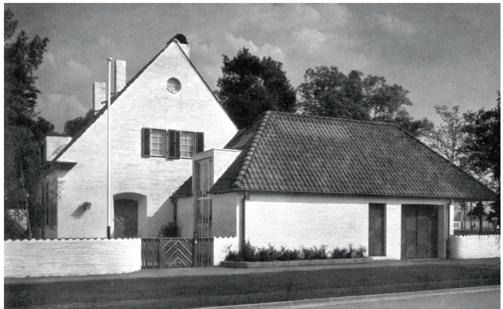
Haus Hentzen, straatgevel met op de voorgrond het atelier en de garage Haus Hentzen, street façade, with the studio and the garage in the foreground
