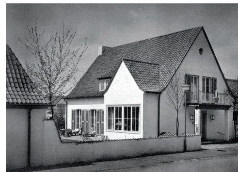
Musterhaus Krall , straatgevel, ca. 1937 Musterhaus Krall , street façade, c. 1937
