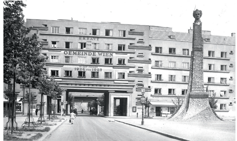
Winarskyhof (1924-1926), een van de Superblocks van Das Rote Wien Winarskyhof (1924-1926), one of the Superblocks of Das Rote Wien
