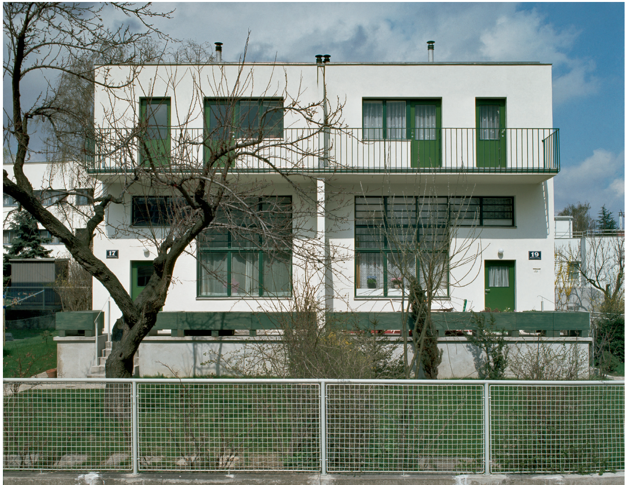
Zuidgevel van de woningen van Loos/Kulka, ca. 1985 South façade of the Loos/Kulka homes, c. 1985
