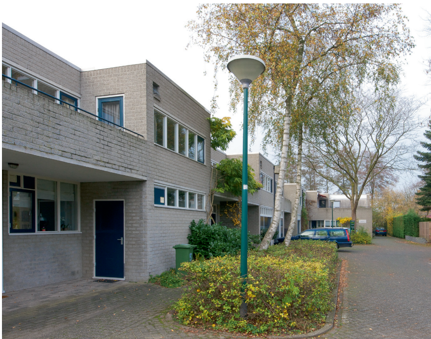
Entreezijde noordwestelijk blok Streetfacade northwest block
