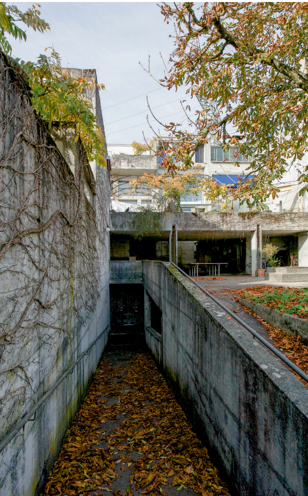
Hellingbaan naar parkeergarage Ramp to parking garage
