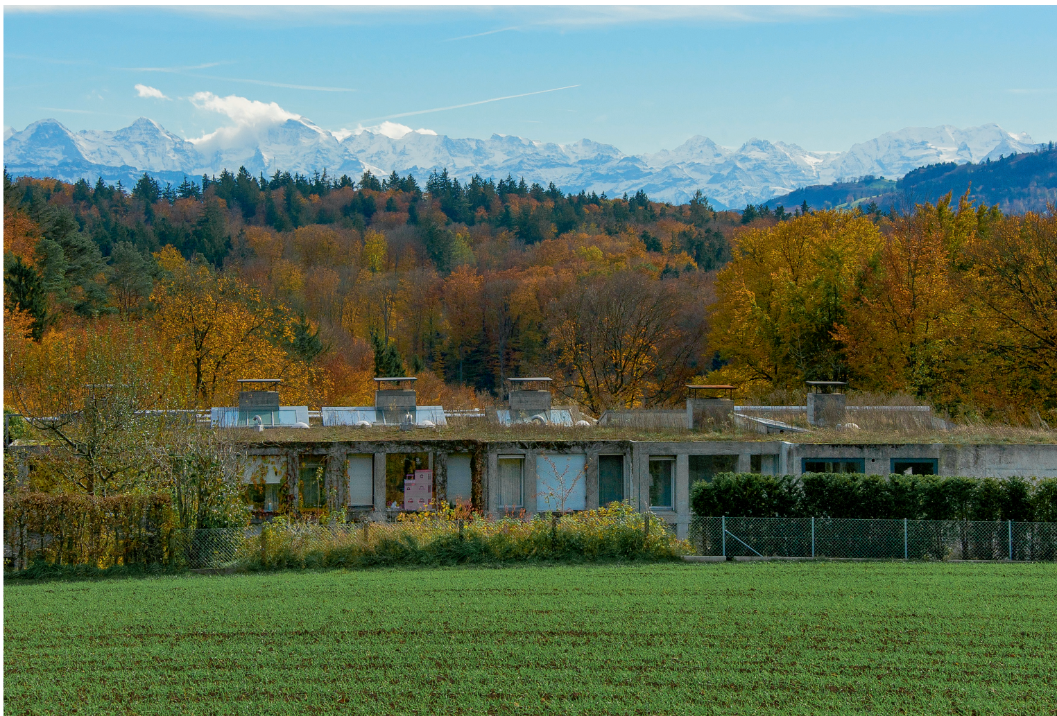
Noordzijde van het project met op de achtergrond het Berner Oberland
