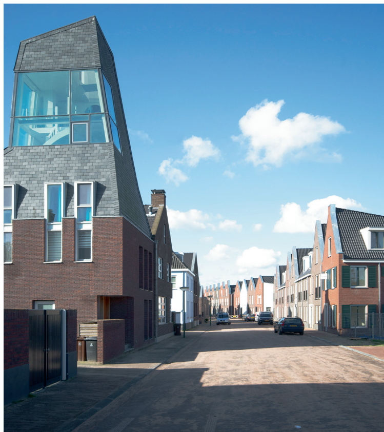
Batsertlaan met torenwoning Bastertlaan with tower dwelling
