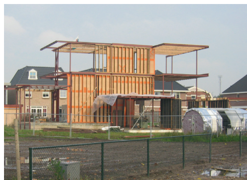
De villa in aanbouw: het staalskelet The villa under construction: the framework
