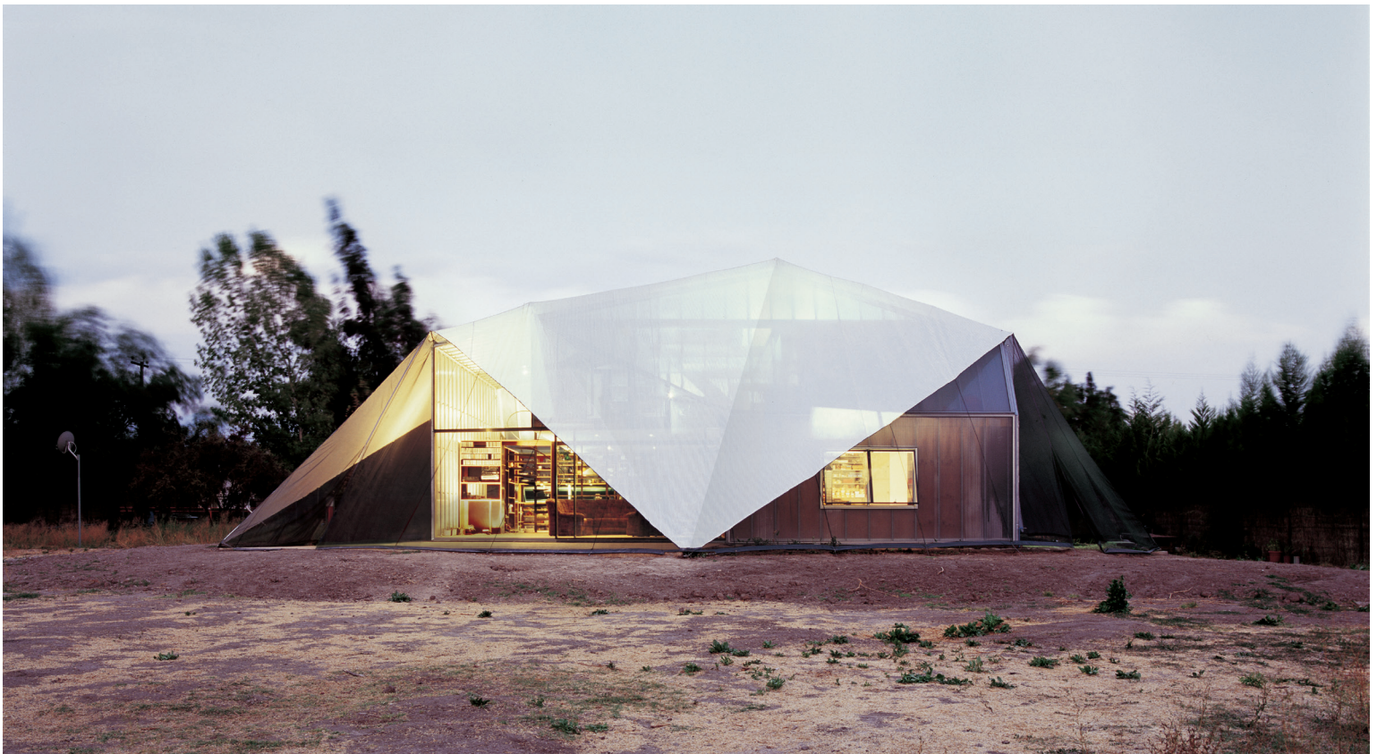
Westgevel West façade
