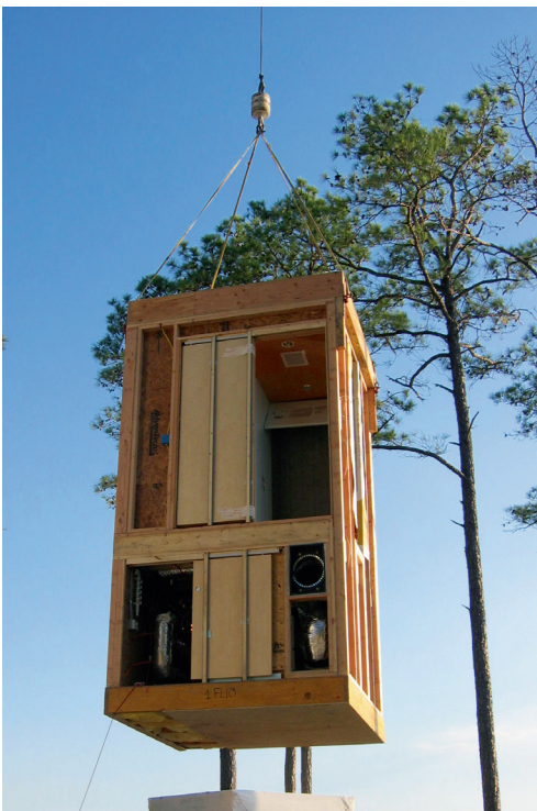
Blok met technische ruimte en badkamer Block with technical room and bathroom
