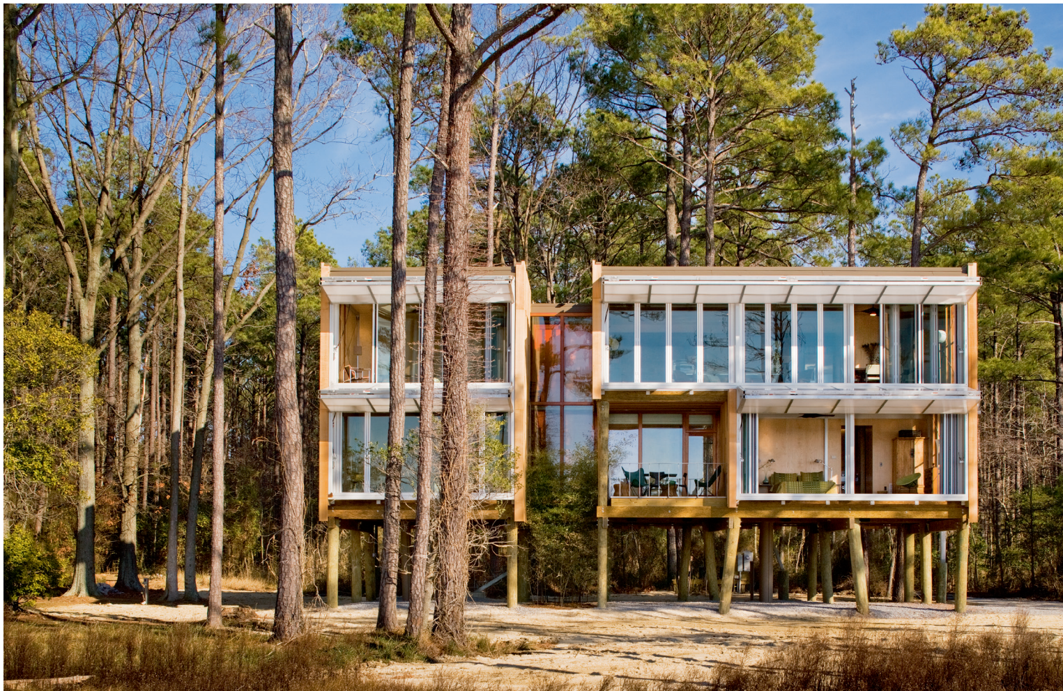
Westgevel West façade
