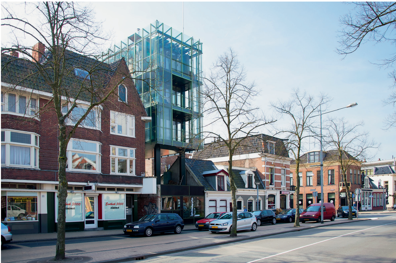
Gevel Gedempte Zuiderdiep Façade on the Gedempte Zuiderdiep
