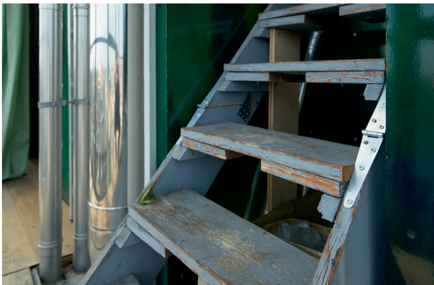
Trap naar het dak Stairs to the roof
