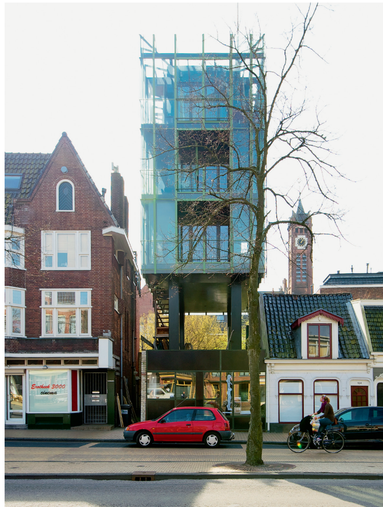
Gevel Gedempte Zuiderdiep Façade on the Gedempte Zuiderdiep
