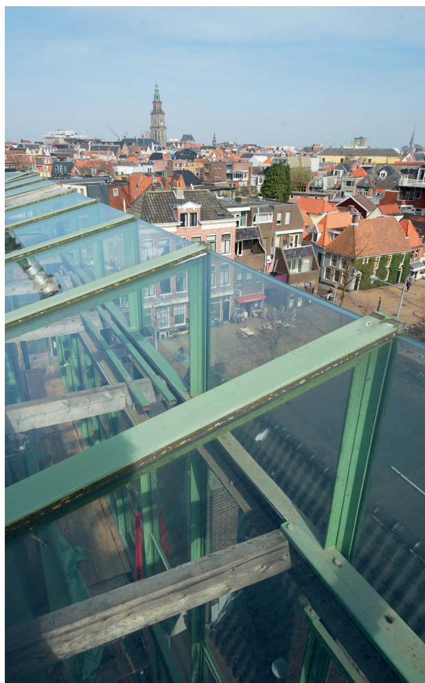
Serre oostzijde vanaf het dak Conservatory facing east, seen from the roof
