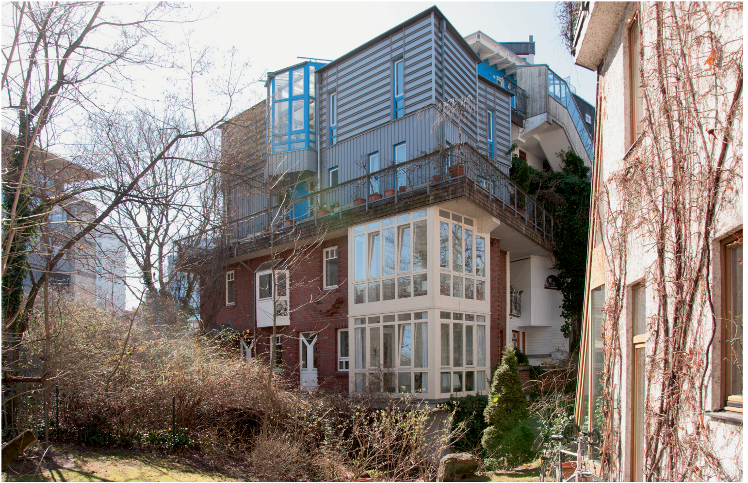
Huis Corneliusstrasse 11, noordoostgevel Corneliusstrasse 11, northeast façade
