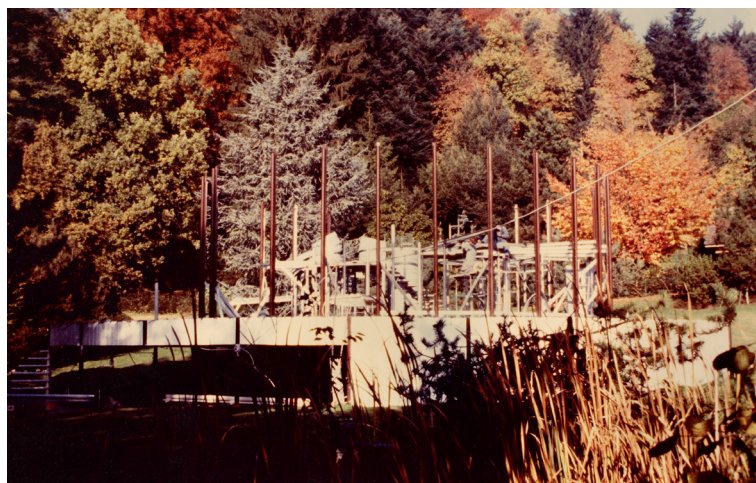
Tijdens de bouw During construction
