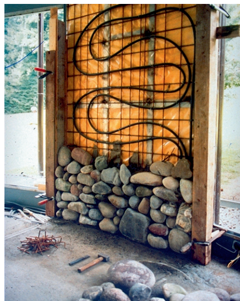
Opbouw van de natuurstenen muren Stone wall under construction
