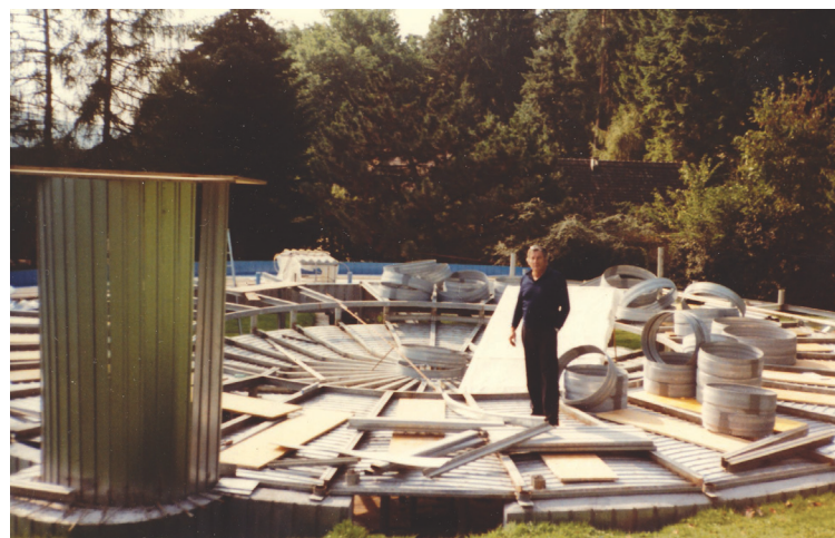
Tijdens de bouw During construction
