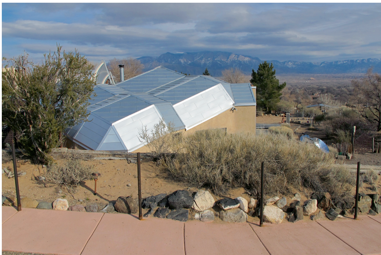
Het nieuwe dak met aluminium shingles The new roof of aluminium shingles
