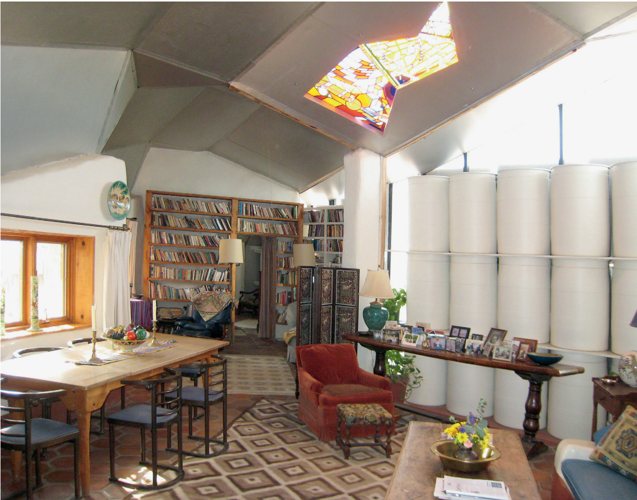
De huidige drum wall met de staande vaten van polyethyleen The current drum wall of standing polyethylene drums
