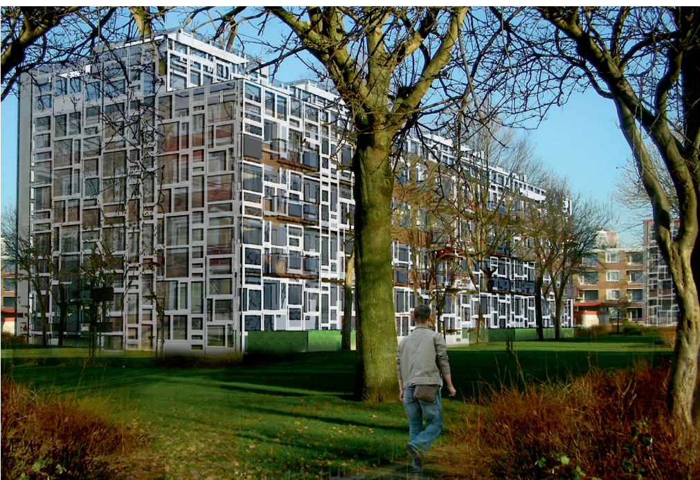
2012Architecten, (No) Flat Future, studie voor een nieuwe gevel van tweedehandskozijnen voor een bestaand woongebouw, 2007 2012Architecten, (No) Flat Future, study for a new façade of second- hand window frames for an existing residential building, 2007
