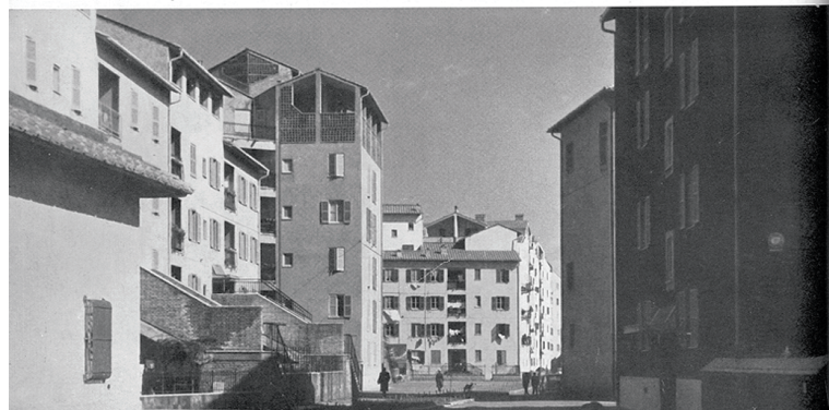
Mario Ridolfi. Fronte nord degli edifici sulla "Piazza"
