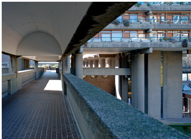
Passage op deckniveau langs de zuidzijde van St Giles Square Passage at deck level along the south side of St Giles Square
