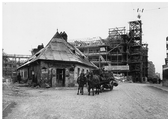
De Rabenhof in aanbouw, ca. 1926 The Rabenhof under construction, c 1926
