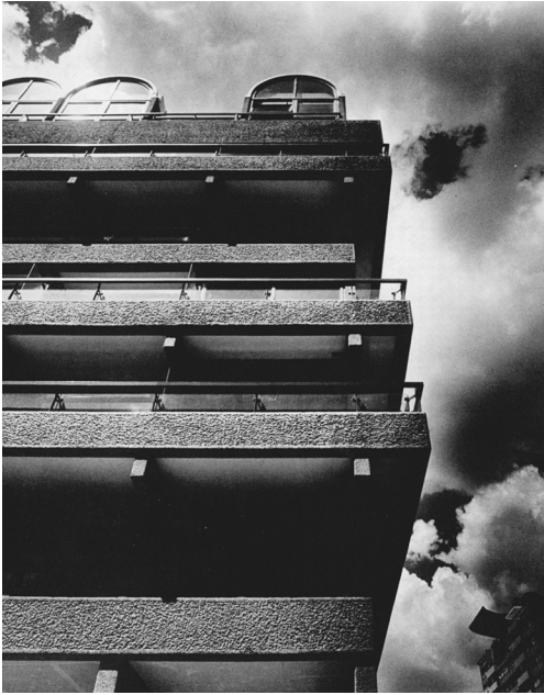
De grof gebouchardeerde betonnen borstweringen The pick-hammered concrete balcony fronts
