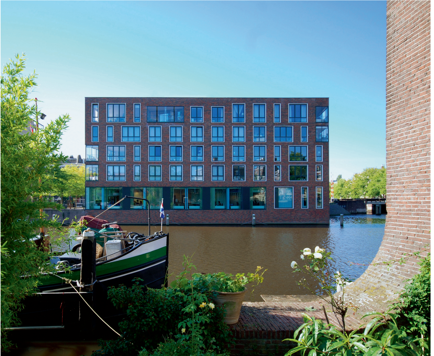
Noordoostgevel gezien vanaf het Entrepotdok North-east elevation seen from the Entrepotdok
