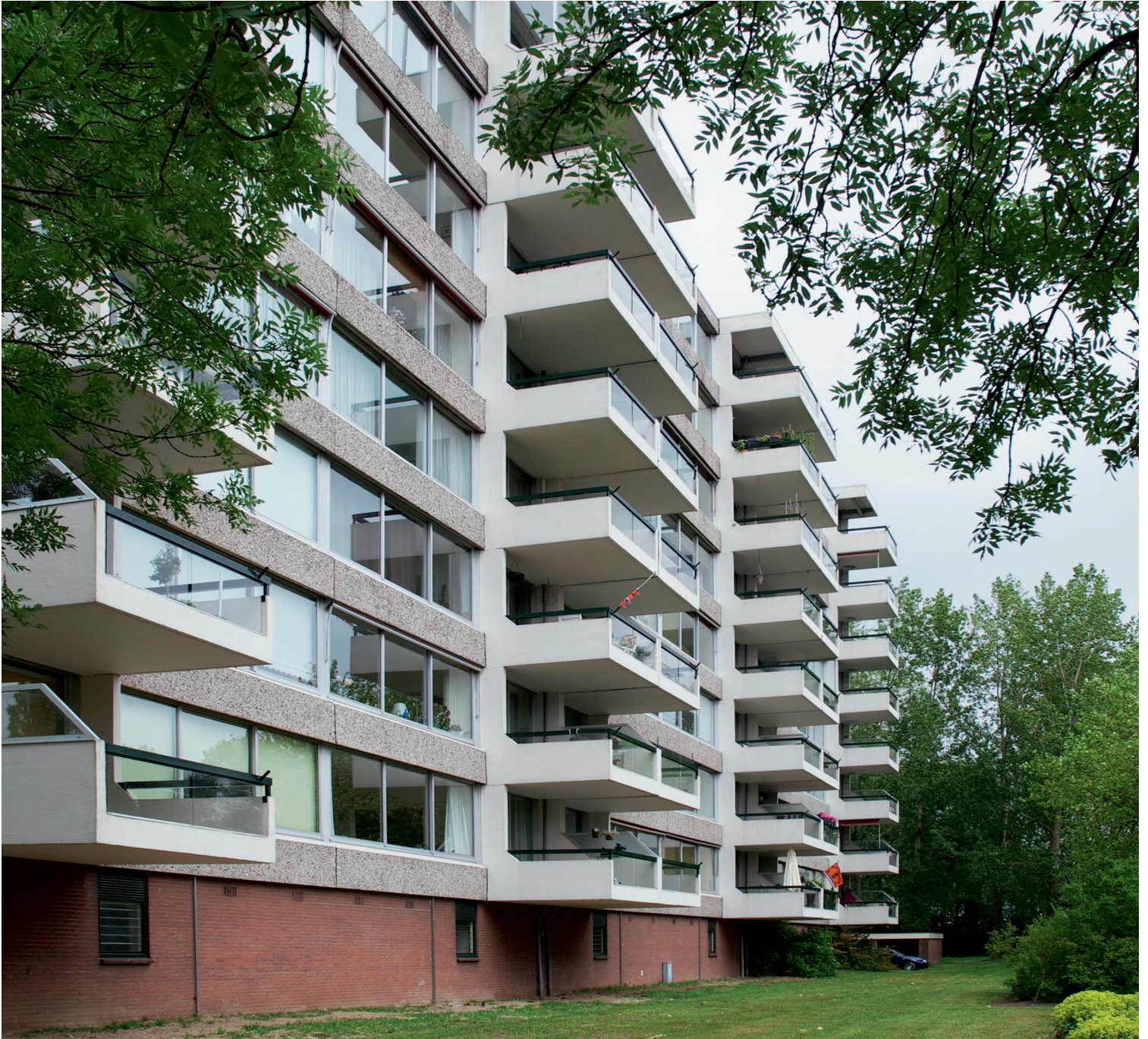
Zuidgevel van één van de noord-zuid georiënteerde blokken South elevation of one of the north-south aligned blocks
