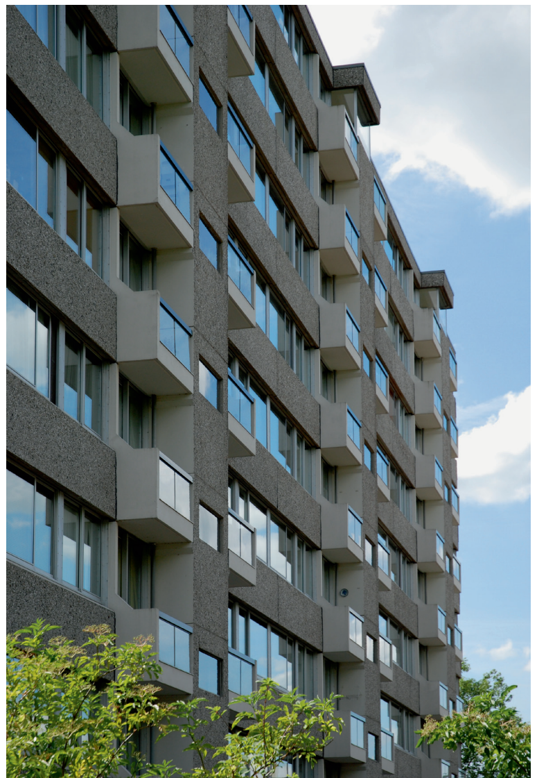
Gevel met kleine balkons aan de keuken Elevation with small balconies to the kitchen
